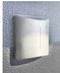
給気口(室外側)(参考写真)
