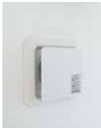
給気口(室内側)(参考写真)
