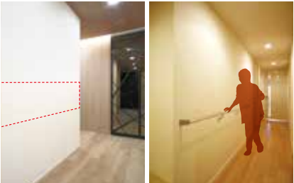
手すり用下地補強(概念図)
