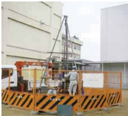
ボーリング調査(参考写真)
